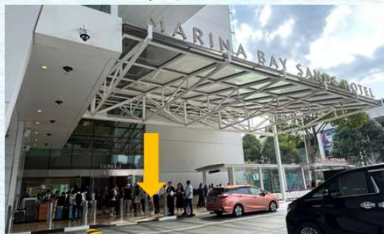
タワー3 正面入口
